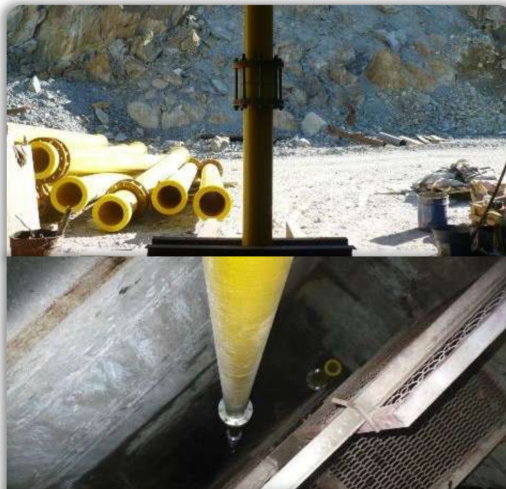
Обустройство шахт, горячее водоснабжение
