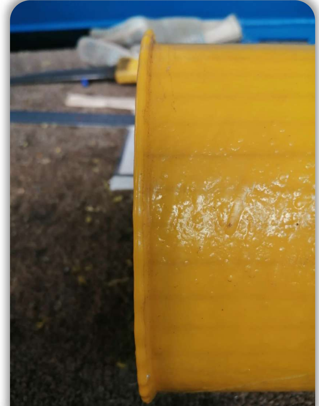
Герметизация каркаса в полевых условиях
