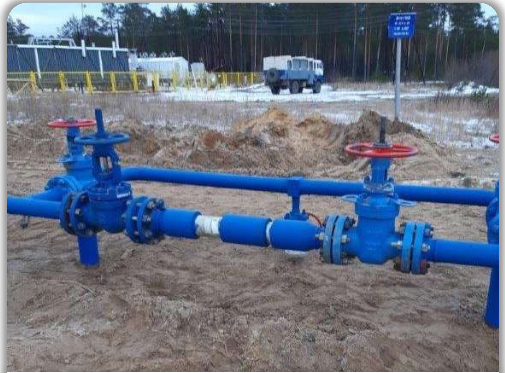
Полигонные испытания МПТ с усиливающим покрытием в системе ППД Сургутнефтегаз
